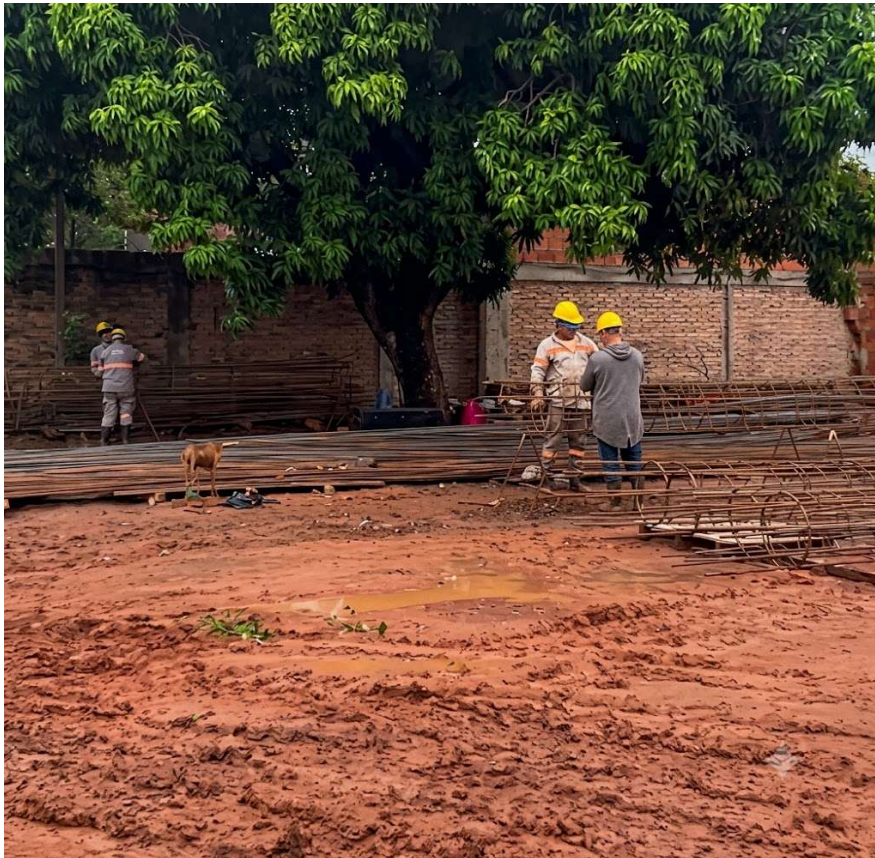
Trabajos de preparación de armaduras para pilotes
